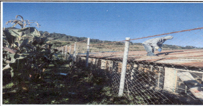
Foto 6: Sustitución de lamina por deterioro y filtración de agua y costanera.
