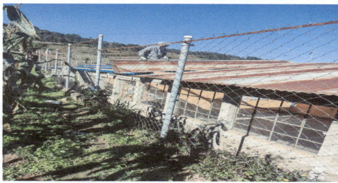
Foto 3: Sustitución de lamina por deterioro y filtración de agua y costanera.
