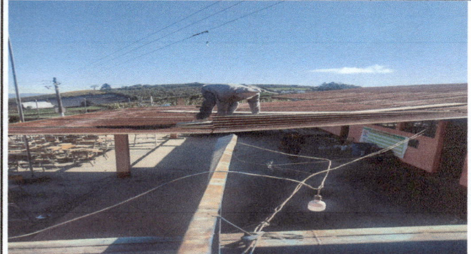
Foto 2: Sustitución de lamina por deterioro y filtración de agua y costanera.
