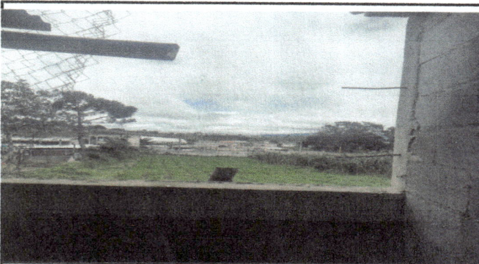
Foto 3: Sustitución de malla por deterioro
