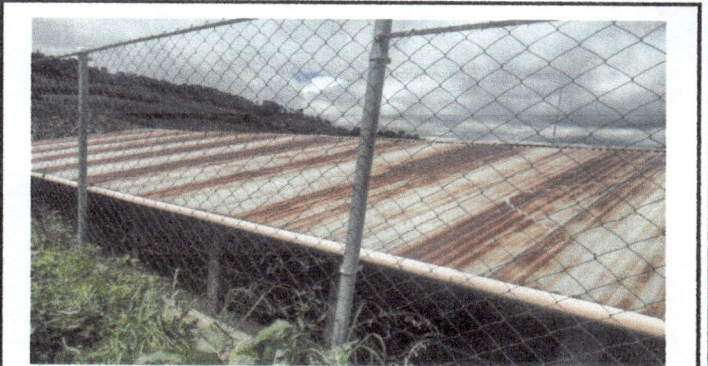
Foto 4: Sustitución de malla por deterioro
