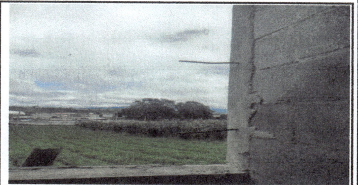
Foto 6: Sustitución de malla por deterioro
