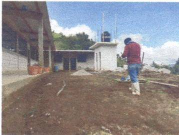
Foto 5: Aplanando el terreno para la losa
