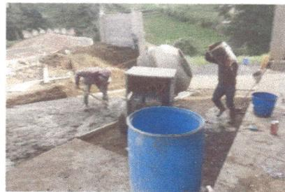
Foto 6: Colocando la losa en el patio.
