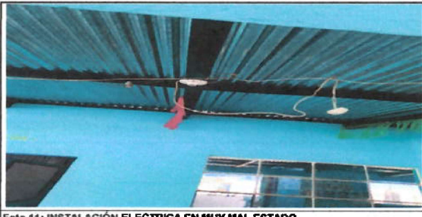
Foto 11: INSTALACIÓN ELÉCTRICA EN MUY MAL ESTADO
