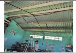
Cambio de instalación eléctria con un total de 125 metros, focos y tomacorrientes.
