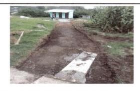
Segunda face de emparejamiento y pavimentación de camino hacia los sanitarios con un largo de 23 metros por 1 metro de ancho y un grosor de 9 centímetros
