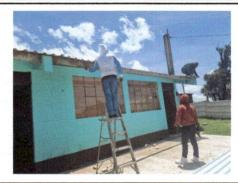
Cambio de techo para direccion, 1 salon y bodega, total 72 metros2 Instalación de cielo falso para 1 salón y dirección, total 54 metros 2
