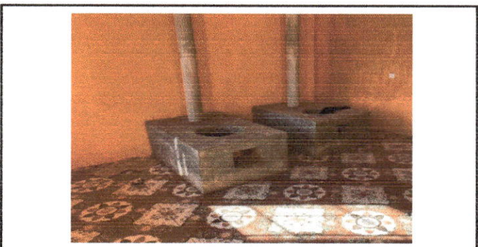
Foto 6: Renglón 8: La cocina cuenta ahora con 2 estufas rurales diseñadas especialmente para la preparación de alimentos en grandes cantidades.
