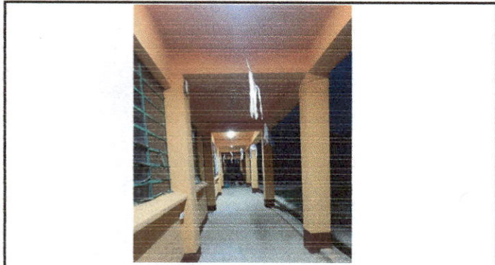
Foto 1: Renglón 13: con el material solicitado se sustituyeron los cables de energía eléctrica de los salones del módulo 1.
