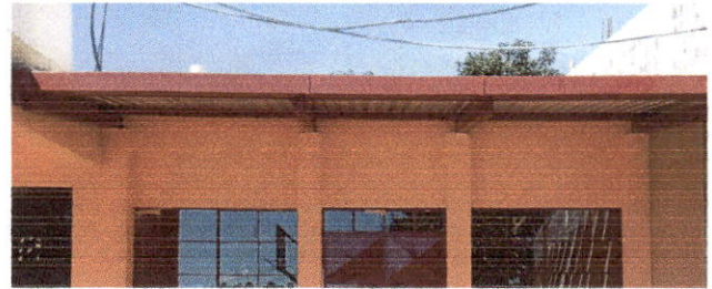
Foto 2: Renglón 1: Se puede observar como el techo ha sido sustituido, no presenta goteras y cubre muy bien el área de cocina.
