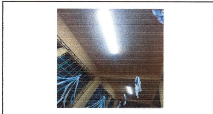
Foto 4: Renglón 13: Todos los salones del módulo 1 cuentan con energía eléctrica.
