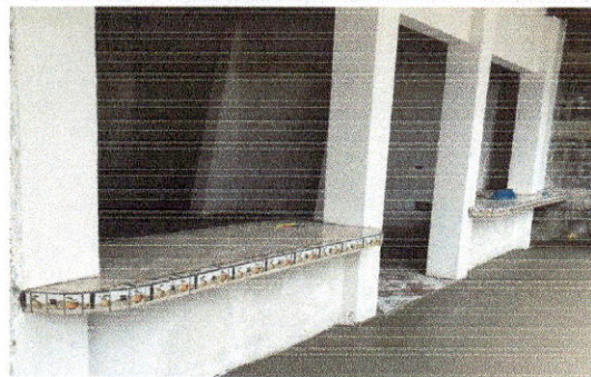
Foto 3: Renglón 12: a la cocina se le colocó cernido de paredes con monocapa blanco también en el área exterior.
