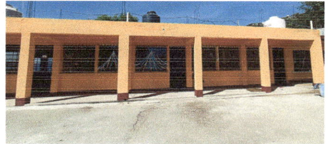
Foto 2: Renglón 4: Pintura en interior y exterior de aulas de módulo 1.
