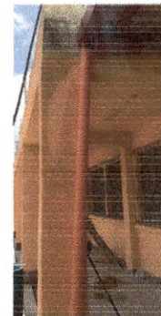
Foto 4: Renglón 3: Se colocaron tubos de pvc para la bajada de agua, en caso de lluvias.
