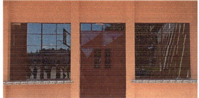
Foto 2: Renglón 10: fueron colocadas 2 ventanas corredizas en la cocina.
