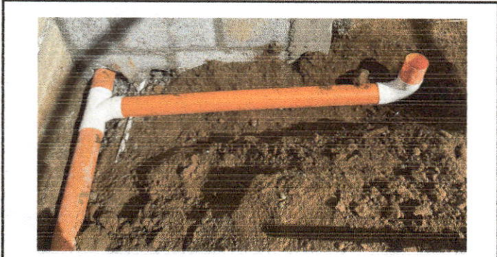
Foto 1: Renglón 7: La cocina cuenta con sustitución de tuberías para aguas negras.
