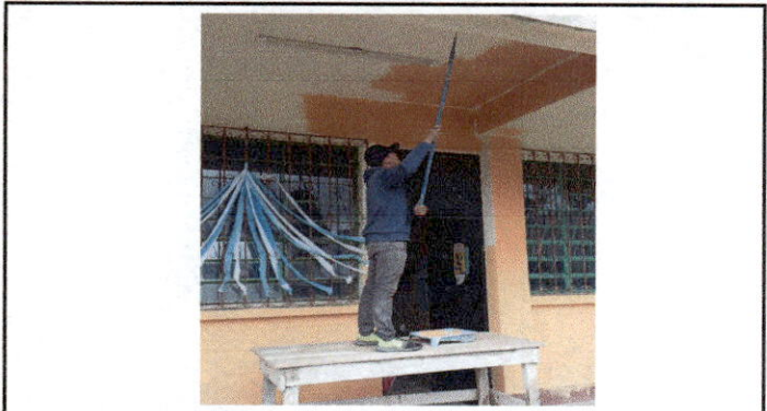
Renglón 4: se pintará las paredes para mejorar la presentación de los salones del módulo 1 y cocina.
