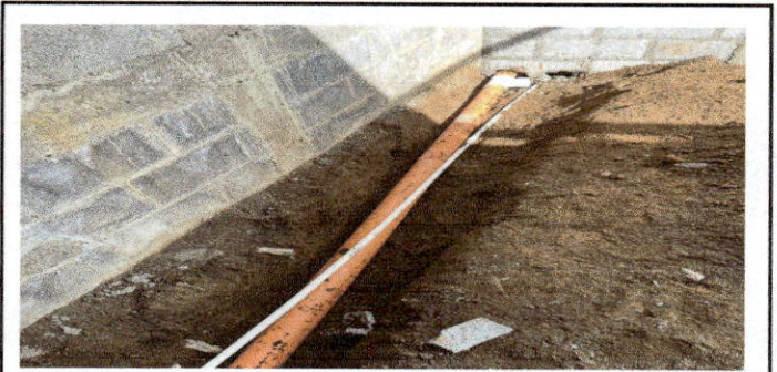
Renglón 6: tubería de agua potable, que servira para lavar los alimentos y los utensilios de cocina.
