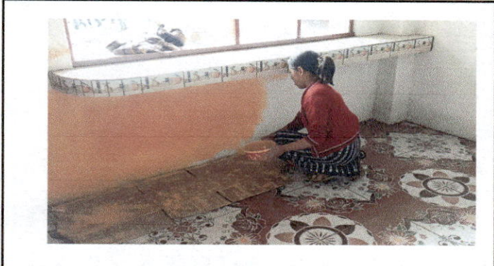
Renglón 4: pintura de paredes dentro y fuera de la cocina y aulas interior y exterior para mejor presentación del establecimiento.
