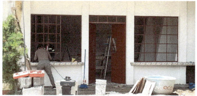
Renglón 10: colocación de ventanas corredizas para brindar una mejor atención a los estudiantes a la hora de despachar alimentos.
