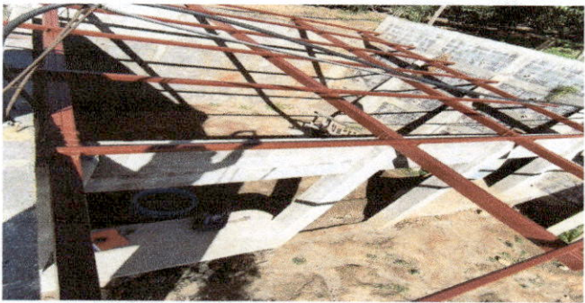
Renglon 2: vigas de costanera para el armazon del techado, la cual nos brindará mayor durabilidad.
