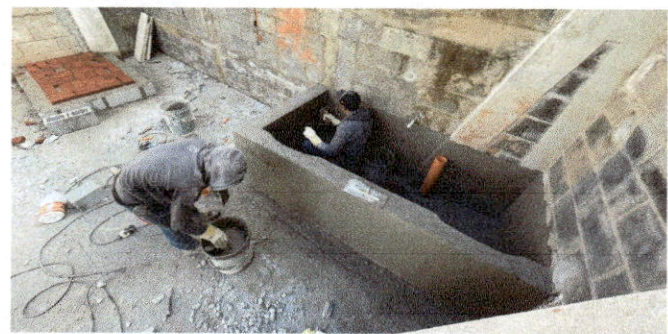
Renglón 9: pila que se utilizará específicamente para lavar alimentos y limpieza de cocina.
