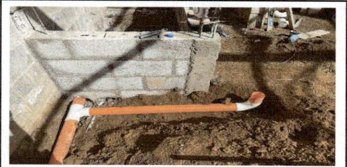
Renglón 6: colocación de tubería el cual trasportara las aguas negras a los drenajes.
