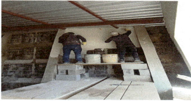
Renglón 7: albañiles trabajando en la remodelación de las diferentes necesidades presentadas.
