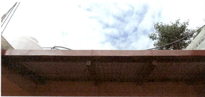
Renglon 3: Sustitución de canales con canales de metal.
