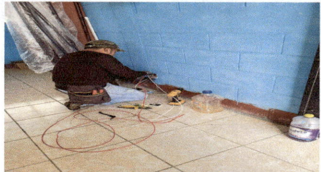
Renglón 7: electricista trabajando para la sustitución de electricidad en módulo 1.
