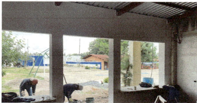
Renglón 11: colocación de puertas para mantener una mayor seguridad.
