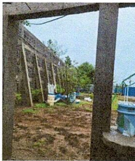
Foto 3: Renglón No. 11. Vista de la puerta desde el interior de la cocina.
