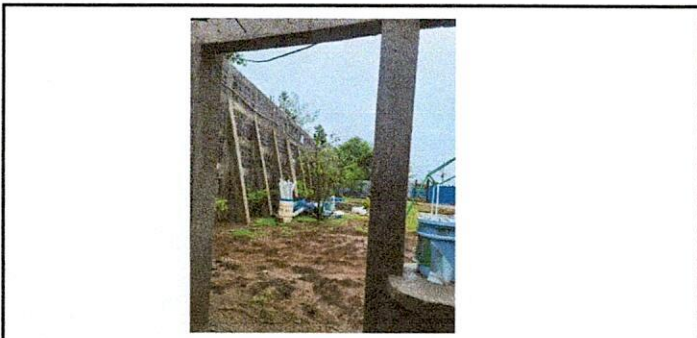
Foto 3: Renglón No. 11. Vista de la puerta desde el interior de la cocina.
