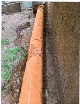
Foto 3: Renglón No. 7. También es importante la mano de obra del plomero para la reparación de las tuberías.
