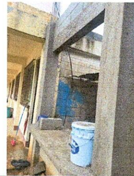
Foto 4: Renglón No. 10. Reparación o sustitución de área de cocina. (ventanas)
