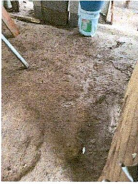
Foto 1: Renglón No. 19 Mano de obra con factura (albañil, herrero, electricista, plomero, entre otros). Es importante la mano de obra para cubrir la tierra con cemento y piso antideslizante
