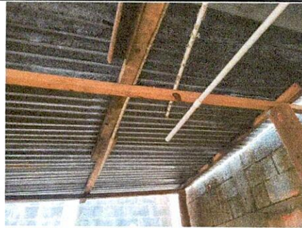
Foto 4: Renglón No. 2 Estructura de techo.
