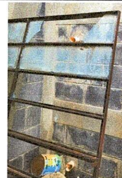
Foto 6: Renglón No. 10. Como se muestra en la fotografía las ventanas ya estan muy deterioradas.
