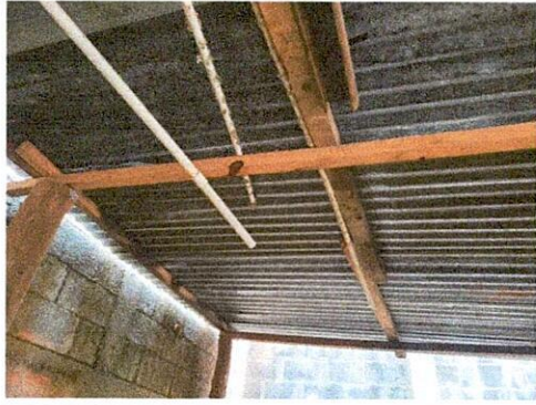
Foto1: Renglón No. 1 Cubierta de láminas
