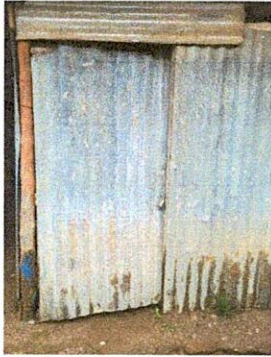
Foto 1: Renglón No. 11. Reparación o sustitución de área de cocina. (puertas)
