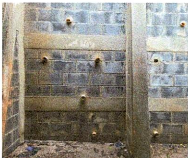
Foto1: Renglón No. 3 Canales y bajadas de agua pluvial.
