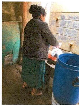
Foto 3: Renglón No. 9. Como se puede observar la pila se encuentra en malas condiciones.
