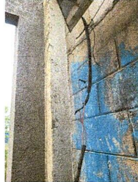
Foto 2: Es importante la mano de obra del electricista para reparación de electricidad.
