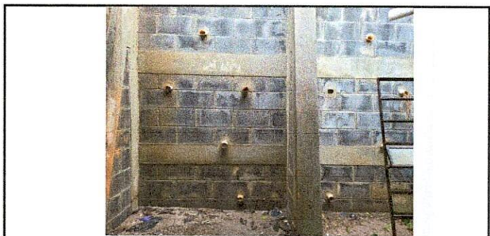
Foto 6: Renglón No. 12. Es necesario el repello y cernido de paredes de la cocina.
