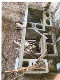
Foto 1: Renglón No. 5. Reparación o sustitución de azulejo en estufa rural.
