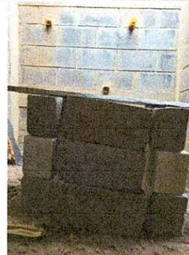
Foto 2: Renglón No. 5. Reparación o sustitución de azulejo en pila.
