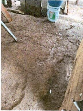
Foto 1: Renglón No. 7. Mano de obra con factura (albañil, herrero, electricista y plomero) Es importante la mano de obra para cubrir la tierra con cemento y piso antideslizante.
