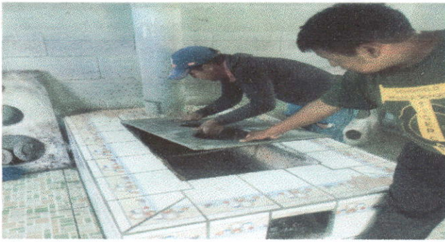
SUSTITUCION DE AREA DE COCINA: Sustitución de planchas de estufa de leña, compra de un lavaplatos, sustitución de chapa.
