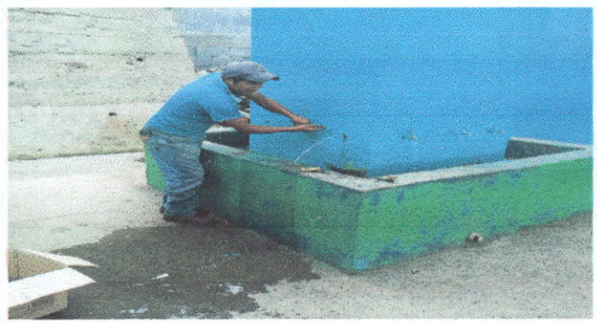
REPARACIÓN Y MANTENIMIENTO DE CISTERNA / DEPÓSITO DE AGUA: Cambio de llaves de chorros y accesorios.
