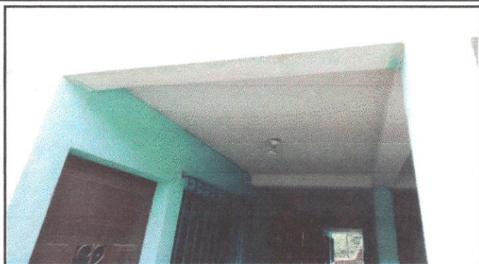
REPARACIÓN DE SISTEMA ELECTRICO: sustitución de cableado y alumbrado de 5 aulas
