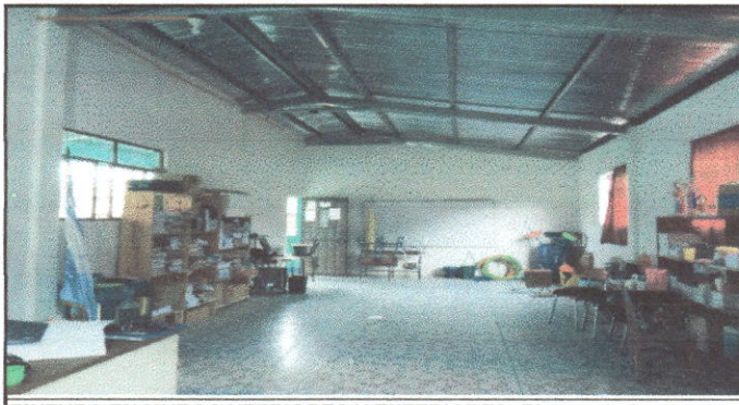
PINTURA EN MUROS INTERIORES Y EXTERIORES: Pintura de 3 aulas, dirección y servicios sanitarios.
