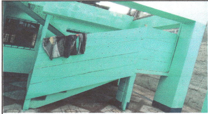
MANTENIMIENTO DE BARANDA: Sustitución de baranda.
