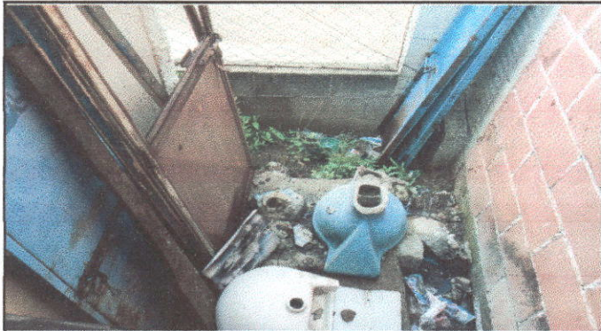
SERVICIO SANITARIO Y ACCESORIO: Sustitución de inodoro, construcción de mingitorio, sustitución de puertas (4 sanitarios)
