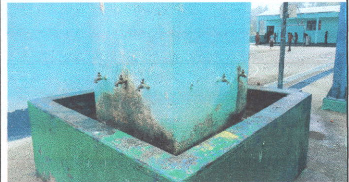
REPARACIÓN Y MANTENIMIENTO DE CISTERNA / DEPÓSITO DE AGUA: Cambio de llaves de chorros y accesorios.
