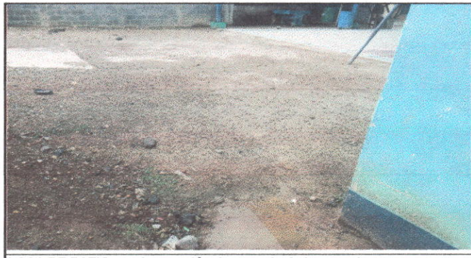
LOSA DE PATIO: pavimentación de entrada de la escuela.
