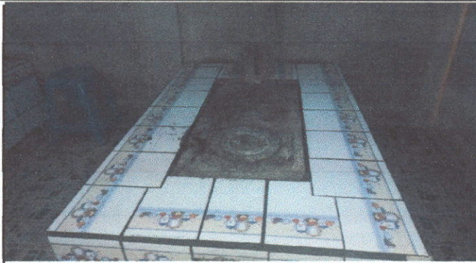
SUSTITUCIÓN DE AREA DE COCINA: Sustitución de esplanas de estufa de leña, compra de un lavaplatos, sustitución de chapa.
