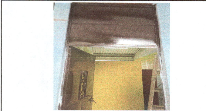
Pintura y reparación de puertas
