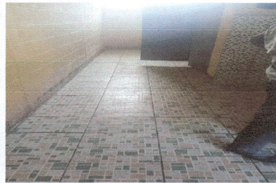
cambio de piso en sanitarios
