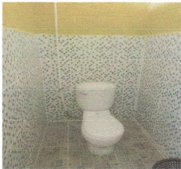
CAMBIO DE TAZAS SANITARIAS
