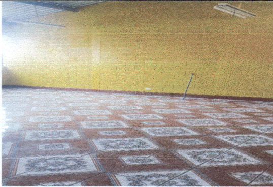
cambio de piso en aulas
