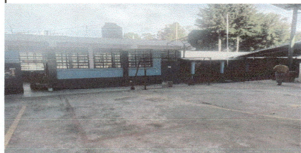
PINTURA EXTERIOR DE AULAS
