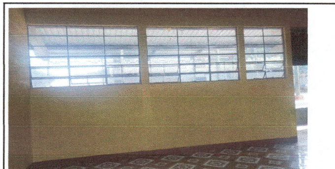
pintura interior de aulas
