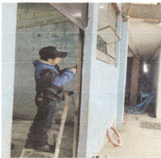
Reparacion de puertas
