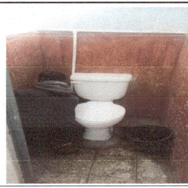
inicio de cambio de piso
