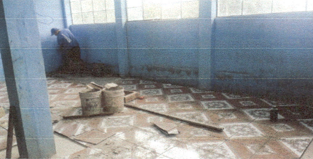
cambio de piso en aulas
