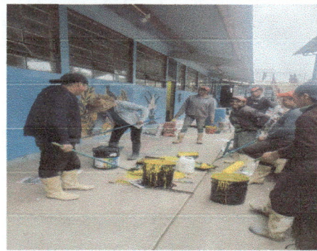
Preparando pintura para interior y exteriores de aulas
