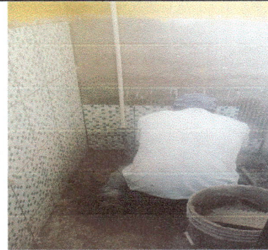
colocación de azulejo en sanitarios
