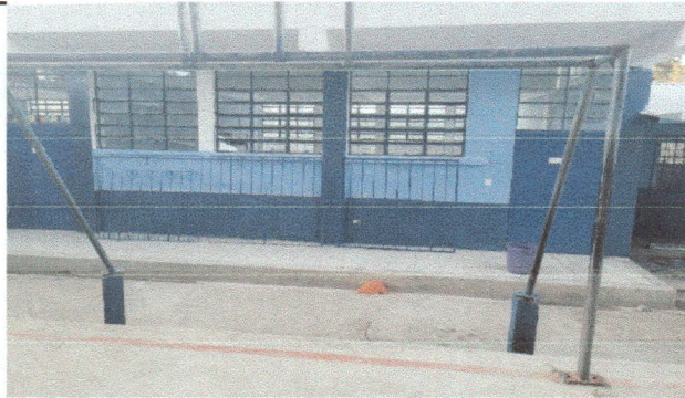
elaboracion y colocación de balcones
