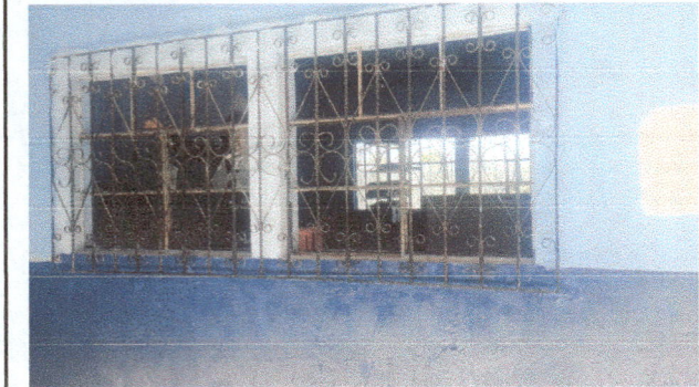
Realizando cambio de vidrios y pintura en balcones
