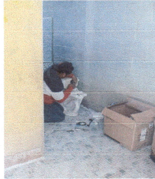
Cambio de quit de sanitarios
