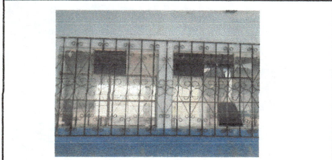
reparacion de ventanas, cambio de vidrios y pintura en balcones
