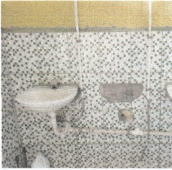
Compra e instalación de lavamanos
