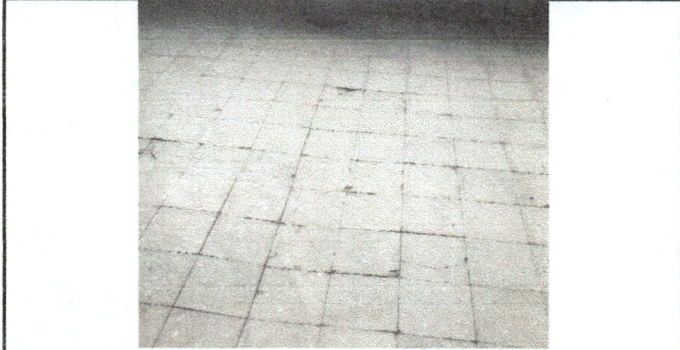
cambio de piso en dos aulas
