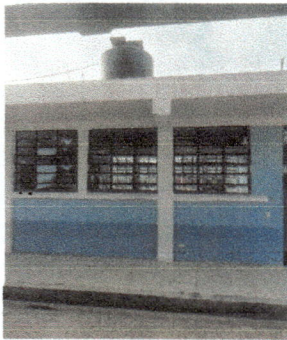
elaboración e instalación de barandas
