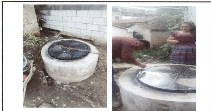
Foto 3: LIMPIEZA Y ESCABACIÓN DE 3 MTS DE POZO ARTESANAL MAS TAPADERA Y COLOCACIÓN DE TUBERÍA PVC)
