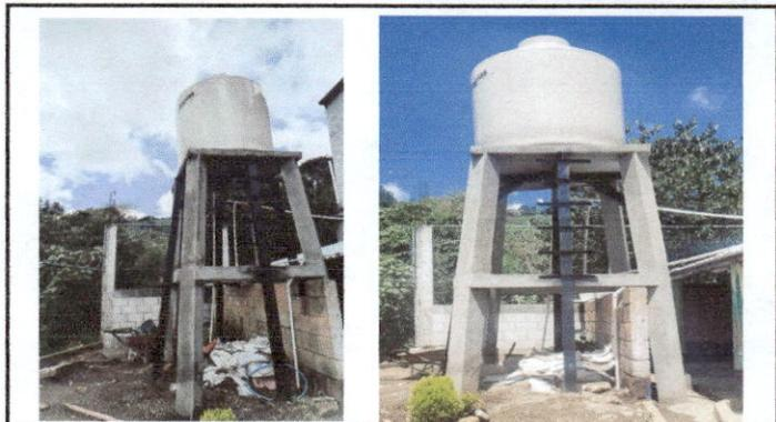
Foto 2: REFORZAMIENTO DE DEPÓSITO DE AGUA 4 COLUMNAS, MAS COLOCACIÓN DE SISTERTNA Y ACCESORIOS.
