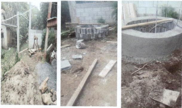
Foto 3: LIMPIEZA Y ESCABACIÓN DE 3 MTS DE POZO ARTESANAL MAS TAPADERA Y COLOCACIÓN DE TUBERÍA PVC)
