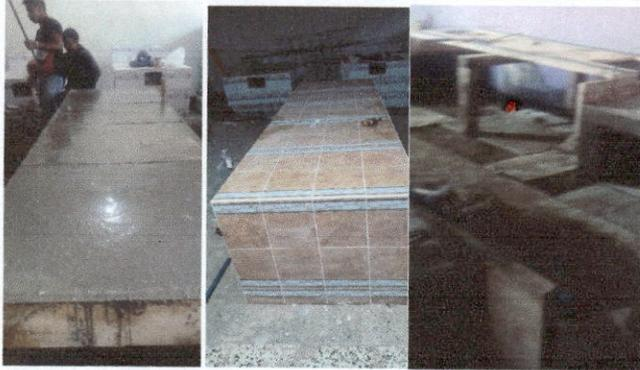
Foto 1: AMPLIACIÓN DE COCINA: LAVASTRATO, DESAYUNADOR, (LEVANTADO DE PISO Y COLOCACIÓN POR LA INTRODUCCIÓN DE TUBERÍA)
