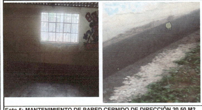
Foto 5: MANTENIMIENTO DE PARED CERNIDO DE DIRECCIÓN 20.50 M2
