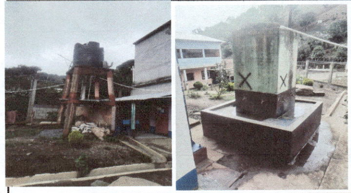
Foto 2: REFORZAMIENTO DE DEPÓSITO DE AGUA 4 COLUMNAS, MAS COLOCACIÓN DE SISTERNA Y ACCESORIOS.
