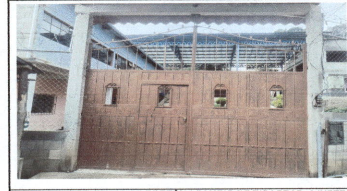
Foto 4: MOJORAMIENTO DE PORTÓN ( CAMBIO DE BISAGRAS, AJUSTE DEL MARCO Y PASADORES, PINTADA DE TODO EL PORTÓN)
