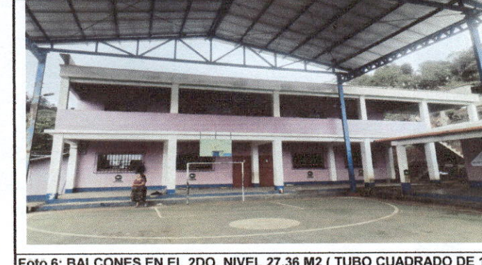
Foto 6: BALCONES EN EL 2DO. NIVEL 27.36 M2 ( TUBO CUADRADO DE 1 PLANO DE 1/2 CON MOLDEDURAS EN LA PARTE DE ABAJO Y ARRIBA.9
