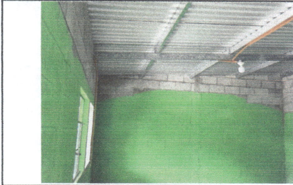
Foto1: Cambio de lámina y estructura de soporte.
