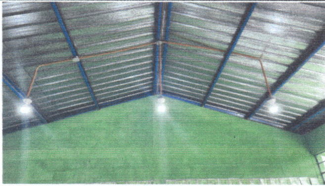
Foto 3: Cambio de candelas y sujetadores por plafoneras y focos led.
