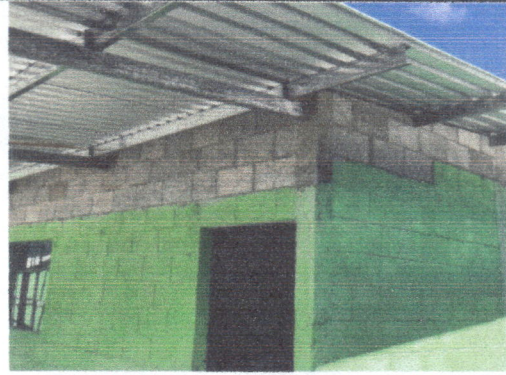
Foto 2: Cambio de forma de techo de 2 aguas a una, ya que la caída de agua en la parte de atrás del salón humedece la pared interior.
