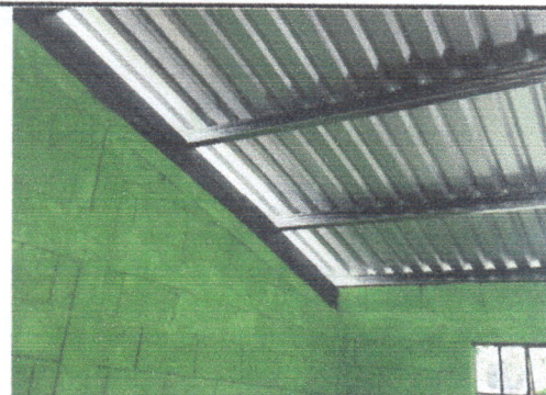
Foto 6: La lámina está picada, requiere cambio.
