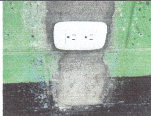
Foto 4: Cambio de cajas rectangulares en mal estado.
