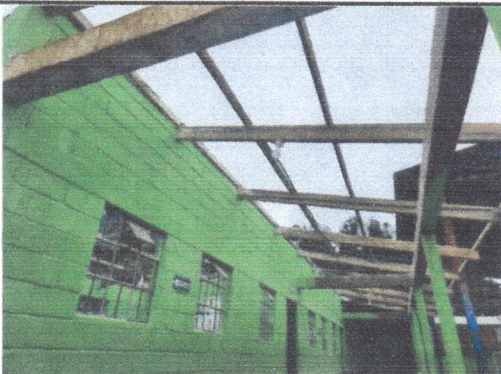
Foto 3: Cambio de soporte, específicamente costanera de madera a costanera galvanizada para dos salones.
