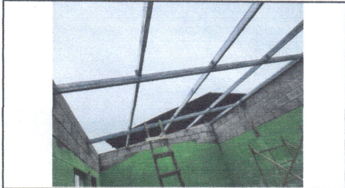
Foto1: Cambio de lámina y estructura de soporte.
