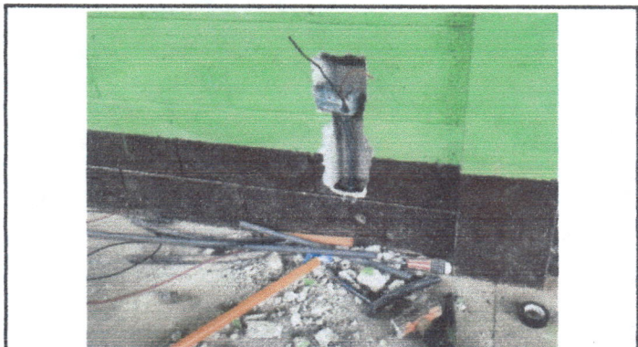
Foto 4: Cambio de cajas rectangulares en mal estado.
