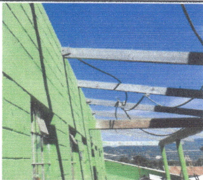
Foto 5: Cambio de capote para no tener filtraciones.
