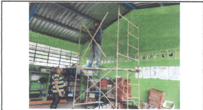
Foto 3: Cambio de candelas y sujetadores por plafoneras y focos led.
