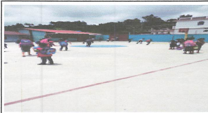
Foto 3: cambio de piso de cancha
