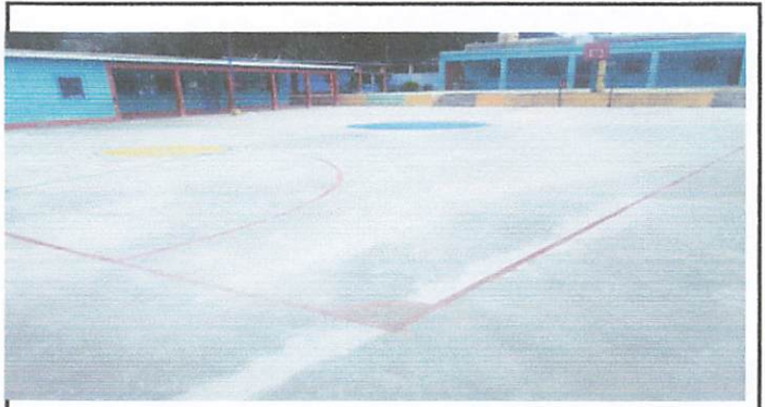
Foto 4: pavimento de suelo
