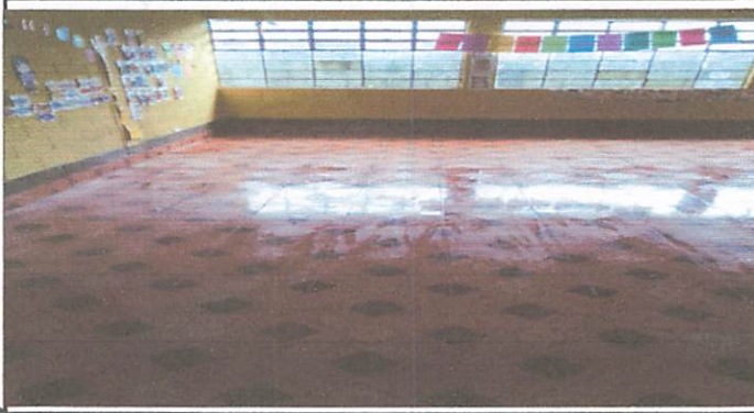
Foto 1: cambio de piso aula de primero primaria.
