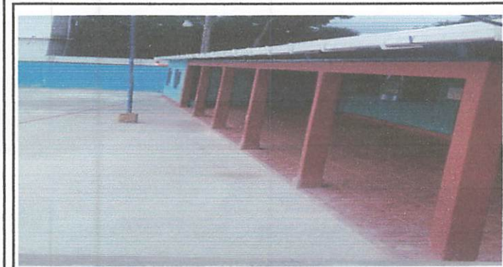
Foto 3: cambio de canales
