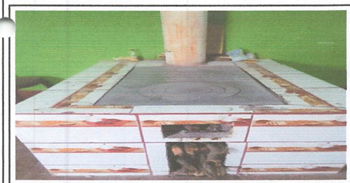
Foto 5: cambio de plancha
