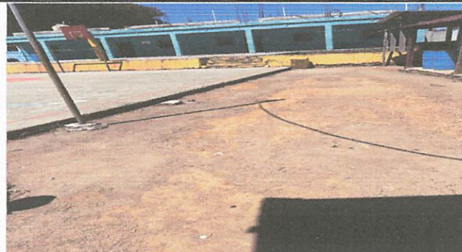
Foto 2: pavimentación del patio
