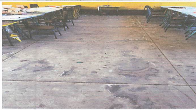
Foto1: cambio de piso aula de primero primaria.
