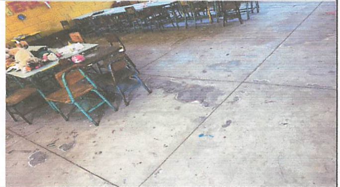
Foto 2: cambio de piso del aula de primero primaria
