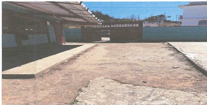
Foto1: pavimentación del patio
