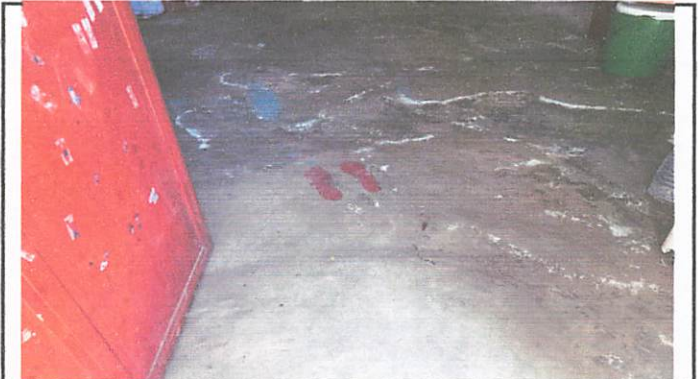
Foto 4: cambio de piso de la bodega
