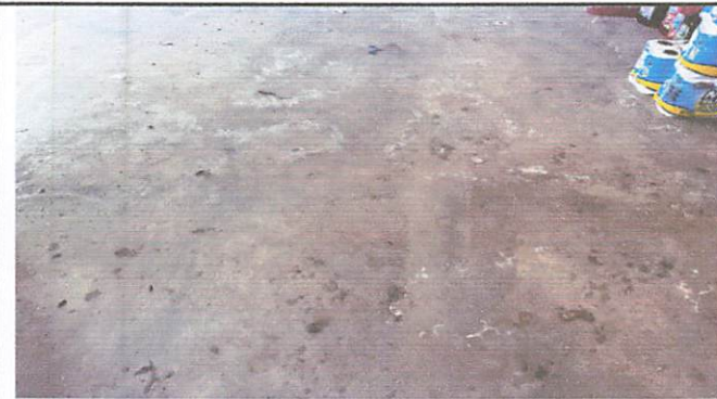
Foto 3: cambio de piso de la bodega
