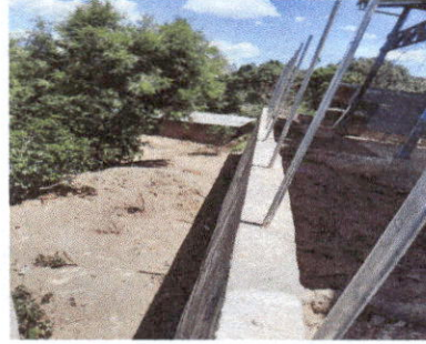
Foto 2: Finalización del muro de contención
