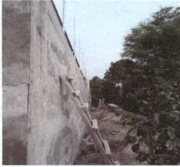
Foto 1: Finalización del muro de contención
