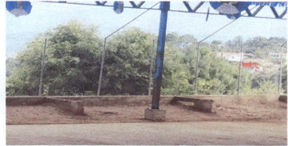
Foto 4: Finalización del muro de contención
