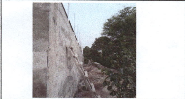
Foto 1: Finalización del muro de contención
