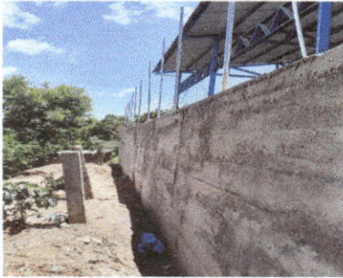
Foto 3: Finalización del muro de contención
