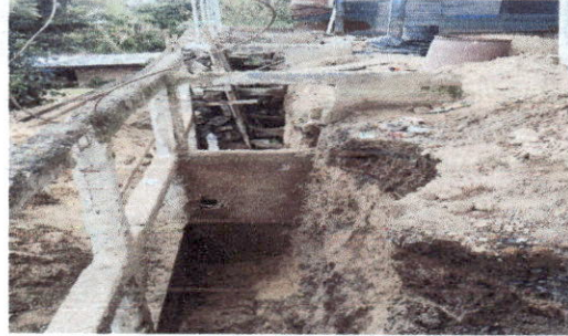
Foto 2: Muro de contención en reparación
