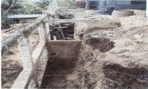
Foto 1: Muro de contención en reparación
