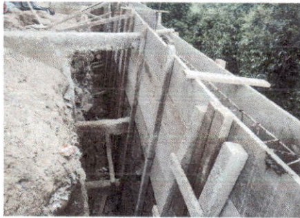
Foto 3: Reparación del muro de contención
