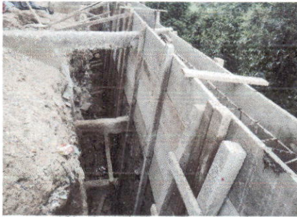
Foto 3: Reparación del muro de contención
