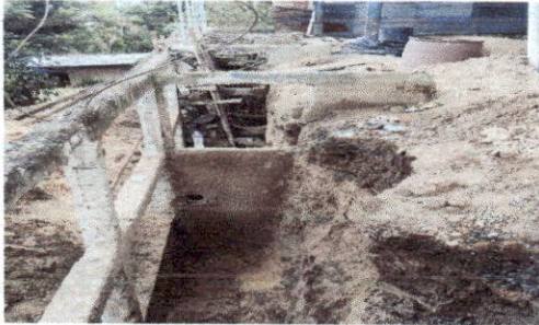
Foto 1: Muro de contención en reparación
