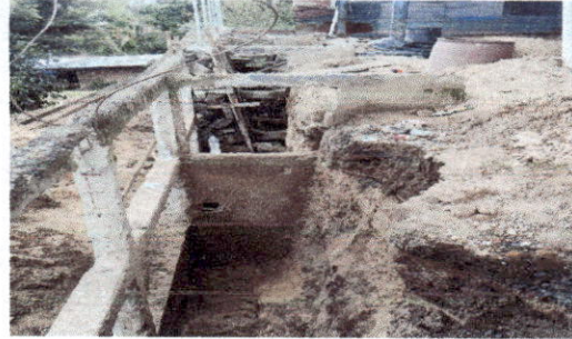
Foto 2: Muro de contención en reparación
