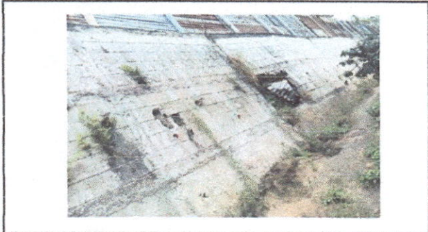
Foto 1: Reparacion de muro de contención
