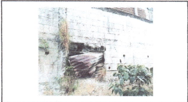
Foto 2: Reparacion de muro de contención
