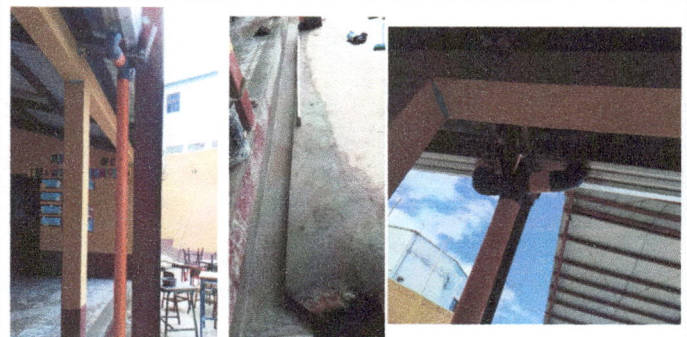
Foto 4: Incorporación de canales de agua.
