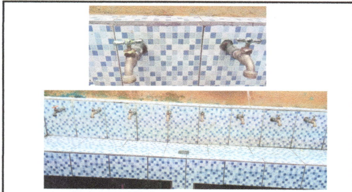
Foto 13: Reparación de chorros de lavamanos.
