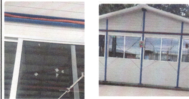
Foto 3: El tendido eléctrico se reparó para evitar cortos circuitos.
