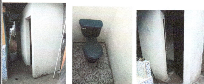
Foto 9: Incorporación de 2 sanitarios en esta área.
