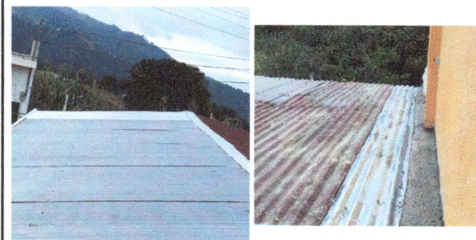
Foto 5: Reparación de láminas en 2 salones.
