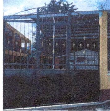
Foto 2: Cambio de portón
