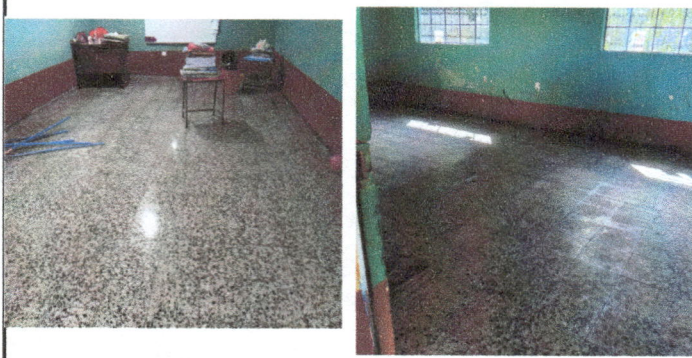
Foto1: Cambio de Piso en 2 salones.
