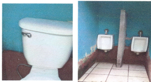
Foto 10: Arreglo de accesorios de sanitarios.
