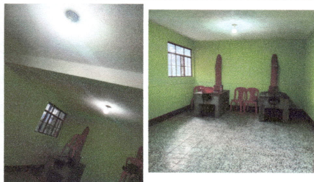
Foto 8: Pintado de cocina y reparación de electricidad.
