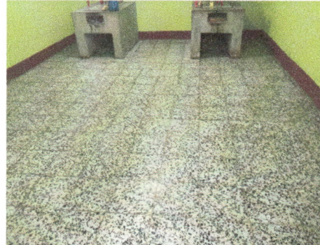
Foto. 6 Cambio de piso en cocina.
