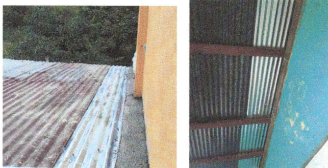
Foto 5: Reparación de láminas en 2 salones.
