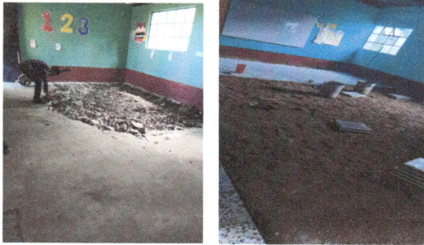
Foto1: Cambio de Piso en 2 salones.
