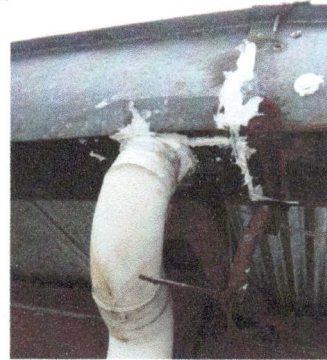
Foto 4: Se arreglan canales de agua en varios puntos.
