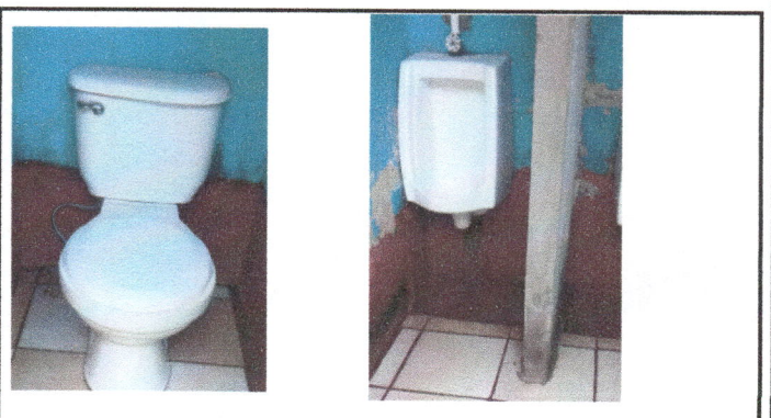
Foto 10: Arreglo de sanitarios, no tienen accesorios para echar agua. En mingitorios una pared divisoria.
