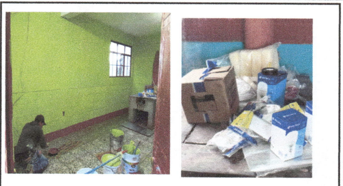
Foto 8: Pintado de cocina y reparación de electricidad.
