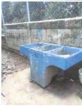
Foto 9: Incorporación de 2 sanitarios en esta área.
