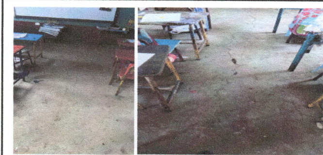
Foto1: Cambio de Piso en 2 salones.
