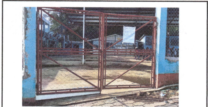
Foto 2: Cambio de portón
