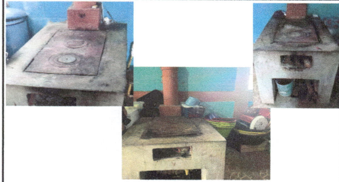
Foto7: Cambio de planchas.
