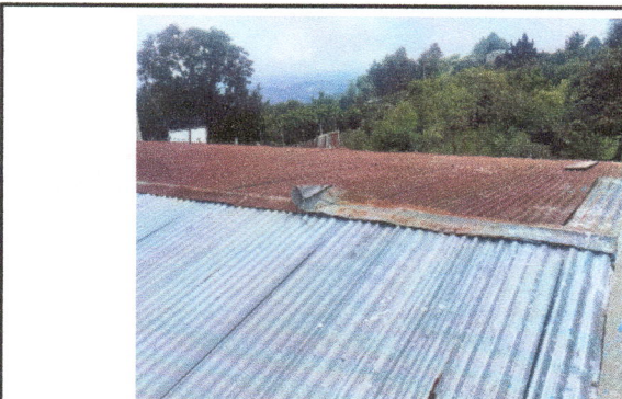
Foto 5: Reparación de láminas en 2 salones.
