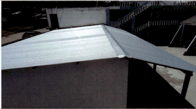
Foto1: Cubierta de lámina.
