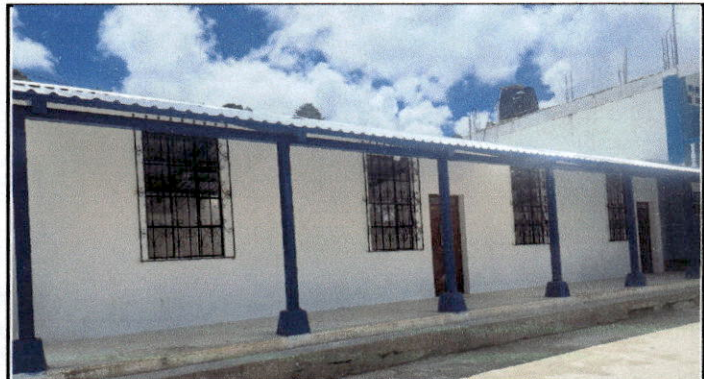
Foto 4: Ventanas: se cambiaron los vidrios de atrás y de delante de los dos salones de clases, también se pintaron los 8 balcones.
