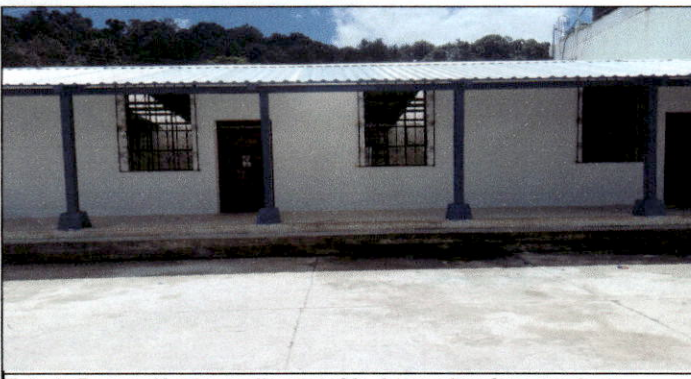
Foto 5: Reparación de repello y cernido de paredes: área exterior e interior.
