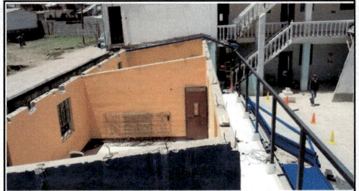
Foto 2: Estructura de techos: Colocación de estructura metálica.
