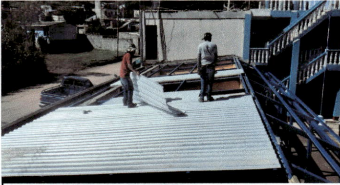
Foto1: Cubierta de lámina: cambiando las láminas.
