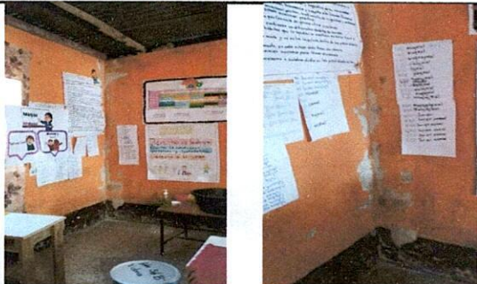
Foto 5: Reparación de repello y cernido de paredes: exterior e interior.
