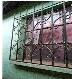
Foto 4: Ventanas: cambio de vidrios, mantenimiento y pintado de balcones.
