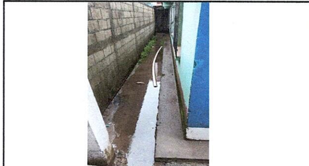
Foto 2: Cunetas de concreto: para las aguas pluviales en época de invierno.
