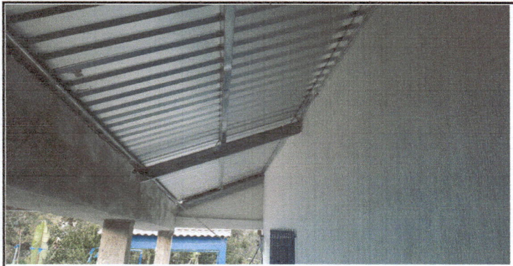
Foto1: Canaleta de concreto y techo de corredor
