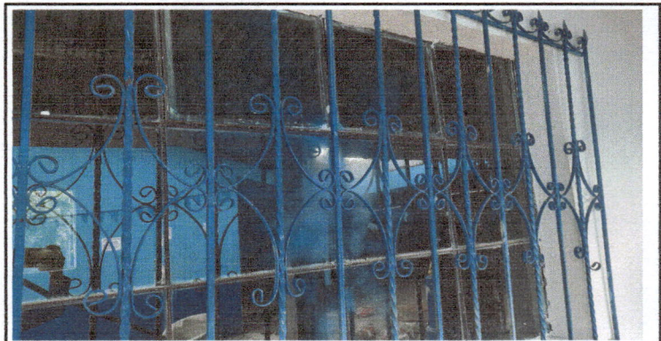
Foto 4: Balcones en ventanas.
