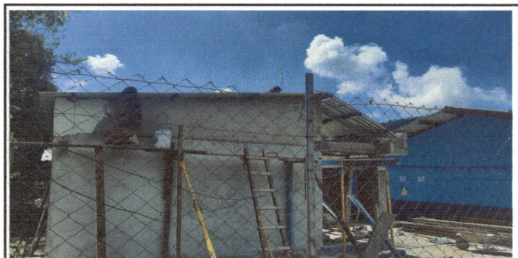
Foto 6: repello de paredes.
