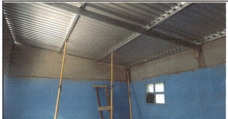
Foto 4: Colocación de vigas y costaneras.
