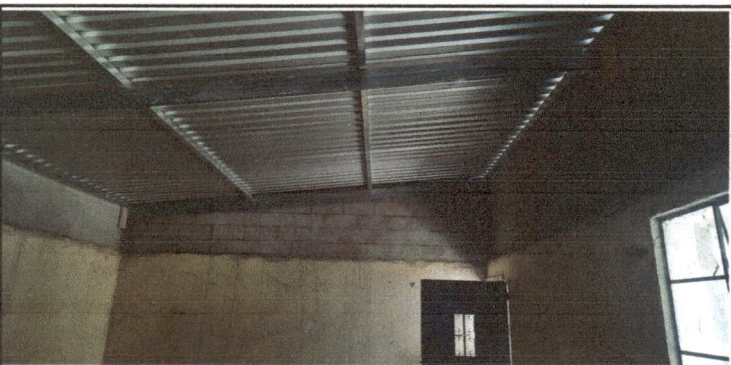
Foto 5: Finalización de techado.
