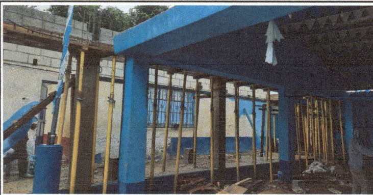
Foto 3: Fundición de canaleta de concreto.
