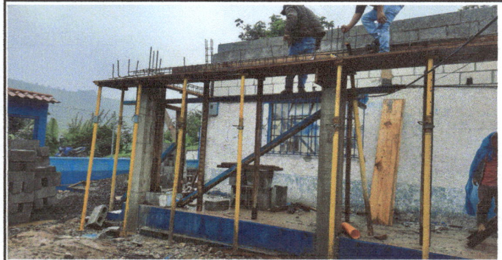
Foto 2: Colocación de bases para canaleta de concreto.
