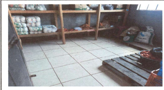
Foto 3: colocación de piso de bodega de cocina
