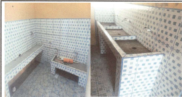
Foto 3: cambio de accesorios de sanitarios y cambio de lavamanos varones No. 6
