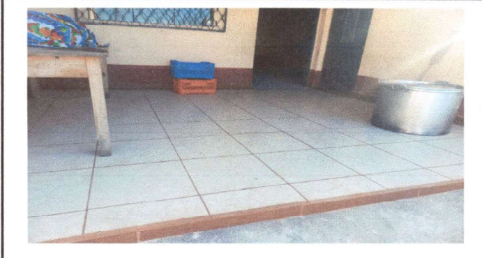
Foto 2: colocación de piso cooredor de cocina
