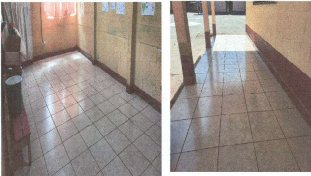
Foto 3: colocación de piso de aula y corredor No. 14 solitaria
