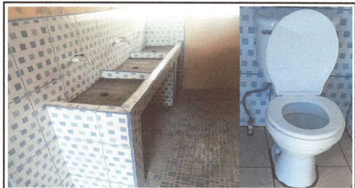
Foto 4: cambio de accesorios de sanitarios y cambio de lavamanos mujeres No. 8
