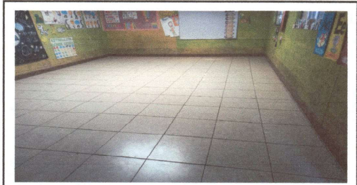
Foto 6: colocación de piso aula No. 20 atrás
