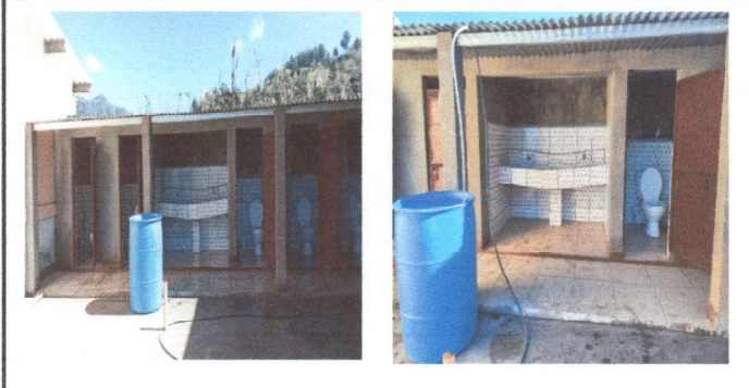
Foto 4: Colocación de pisos y azulejos en sanitario- abajo
