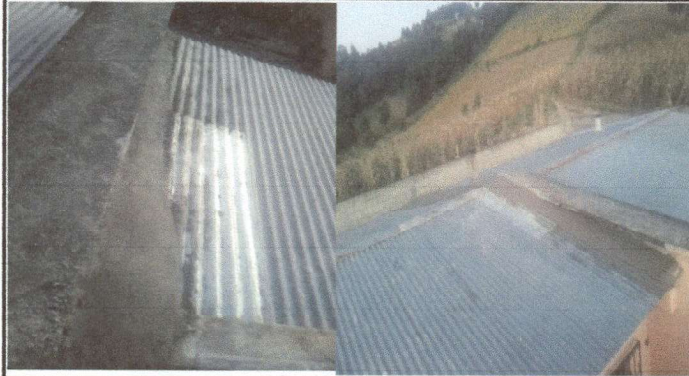
Foto1: arreglo de techo de lámina aula No. 3
