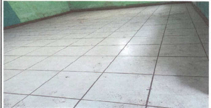
Foto 2: colocación de piso aula No. 22 atrás
