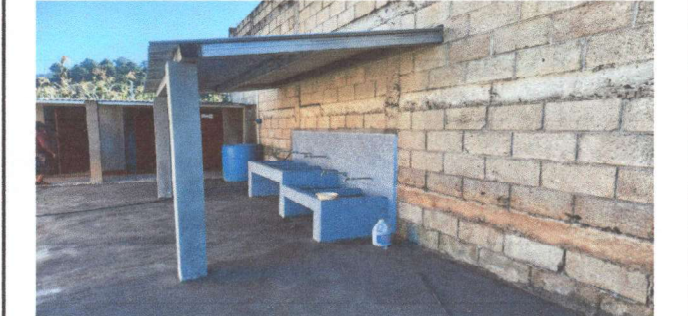
Foto 6: ampliación de pilas -abajo
