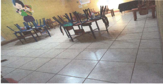
Foto1: colocación de piso aula No. 21 atrás
