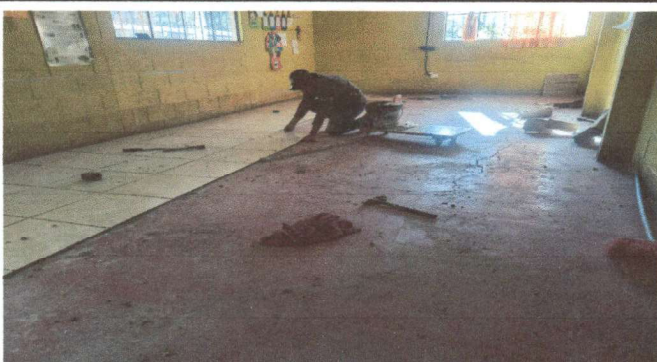
Foto 3: colocación de piso de aula y corredor No. 14 solitaria
