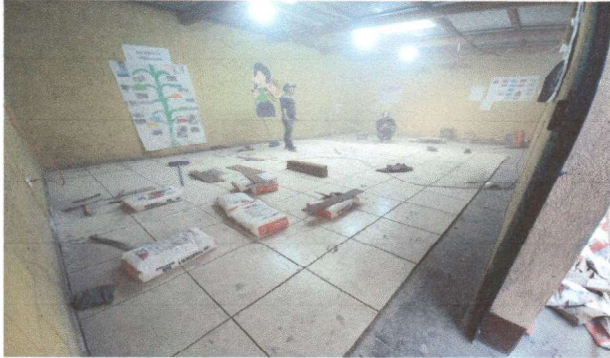
Foto 1: colocación de piso aula No. 21 atrás
