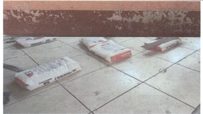
Foto 2: colocación de piso cooredor de cocina
