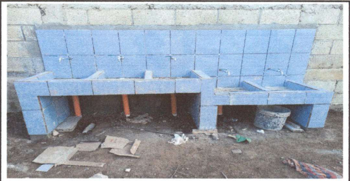
Foto 6: ampliación de pilas -abajo
