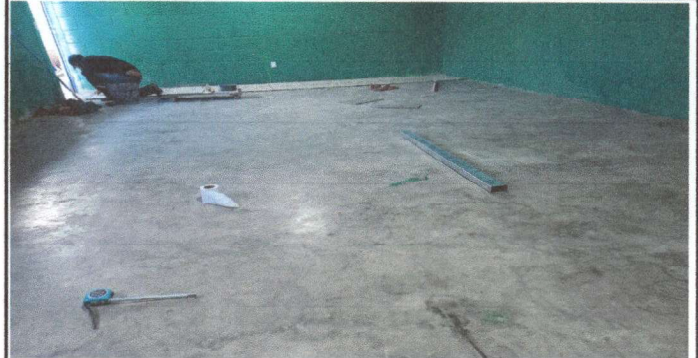
Foto 2: colocación de piso aula No. 22 atrás
