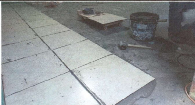
Foto 3: colocación de piso de bodega de cocina
