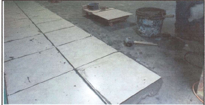
Foto 6: colocación de piso aula No. 20 atrás
