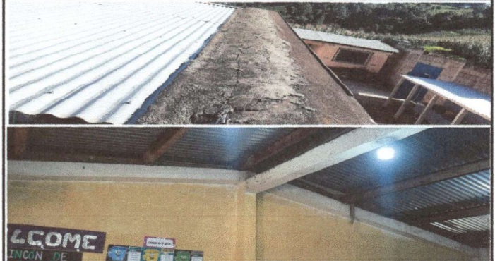
Foto 2: arreglo de techo de lámina aula No. 18
