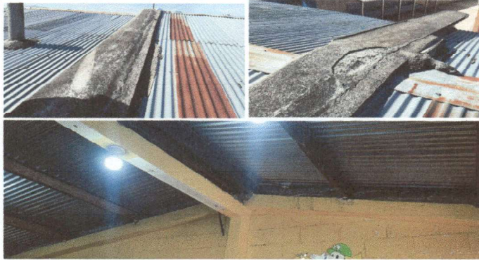
Foto 1: arreglo de techo de lámina aula No. 3
