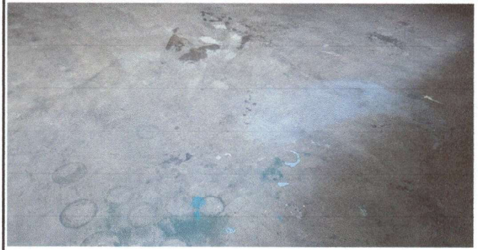
Foto 2: colocación de piso aula No. 22 atrás
