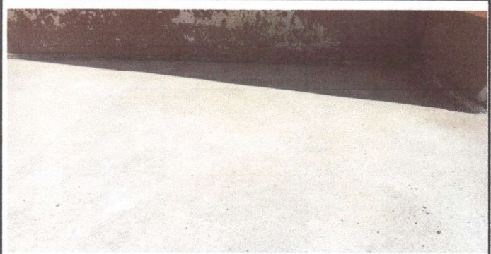
Foto 2: colocación de piso cooredor de cocina
