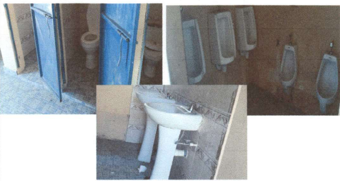
Foto 3: cambio de accesorios de sanitarios y cambio de lavamanos varones No. 6
