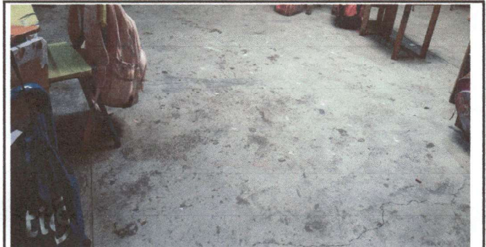
Foto 6: colocación de piso aula No. 20 atrás
