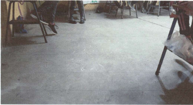
Foto 1: colocación de piso aula No. 21 atrás
