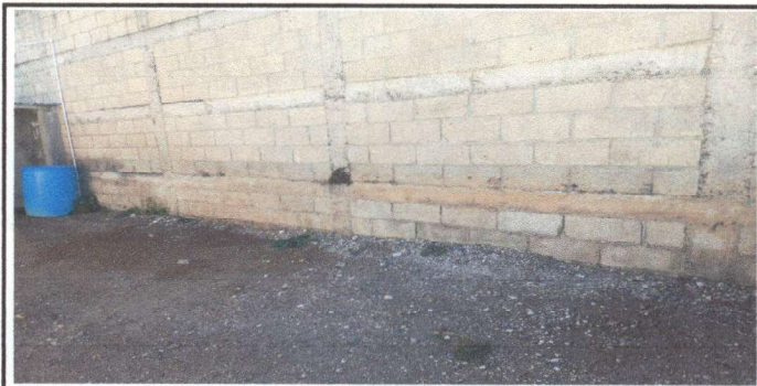
Foto 6: ampliación de pilas -abajo
