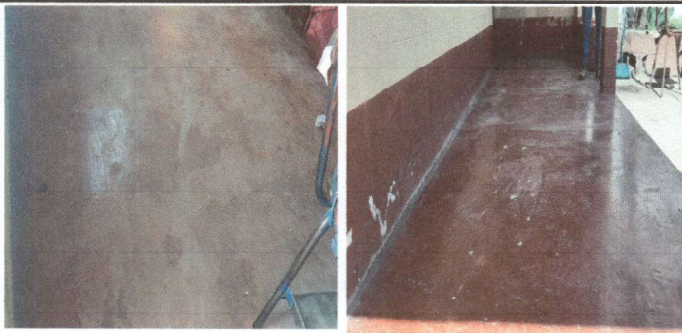
Foto 3: colocación de piso de aula y corredor No. 14 solitaria
