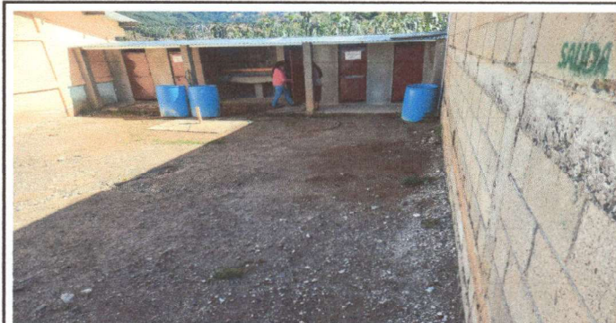
Foto 4: colocación de piso y azulejo en sanitario -abajo
