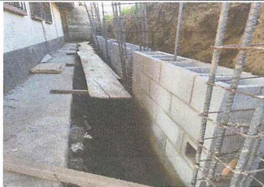
Foto 2: Reparación de muro perimetral
