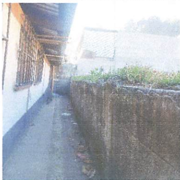
Foto 1: reparación de muro de contención
