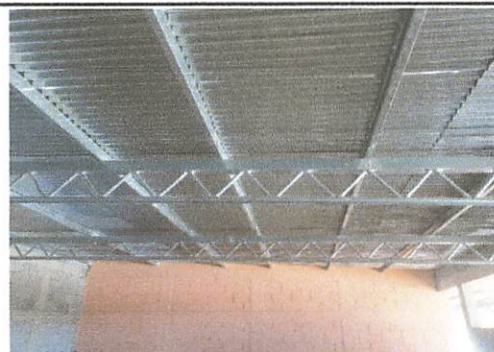
Foto 6: se necesita instalación eléctrica dentro del aula
