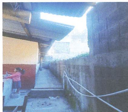
Foto 2: Reparación de muro perimetral
