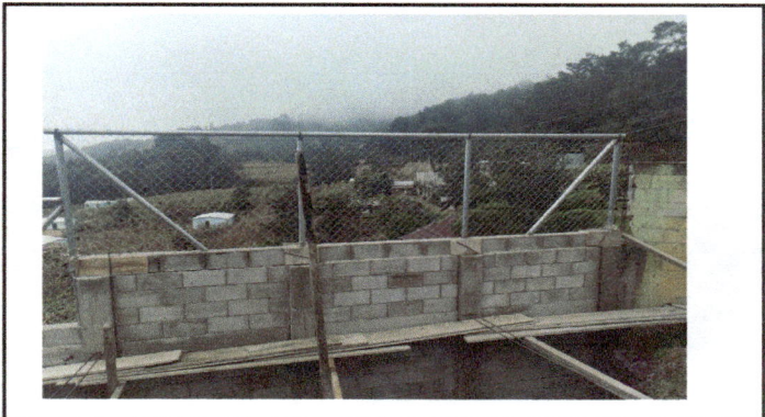
Foto 4: Pared restaurada y con malla galvanizada, vista interna.
