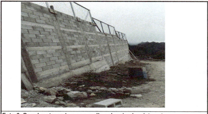
Foto 6: Pared restaurada y con malla galvanizada, vista externa.
