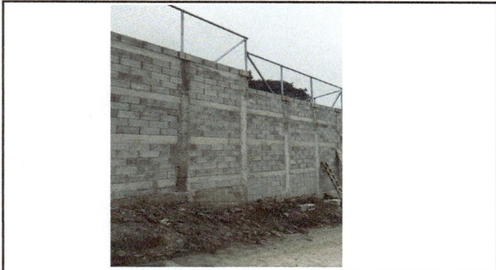
Foto 3: Pared restaurada y con malla galvanizada.
