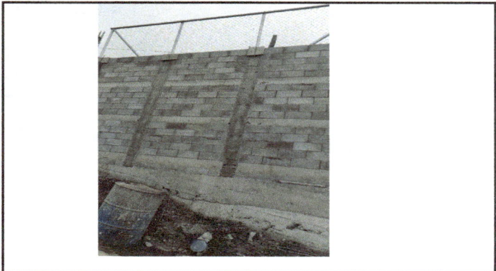
Foto 2: Pared restaurada y con malla galvanizada.
