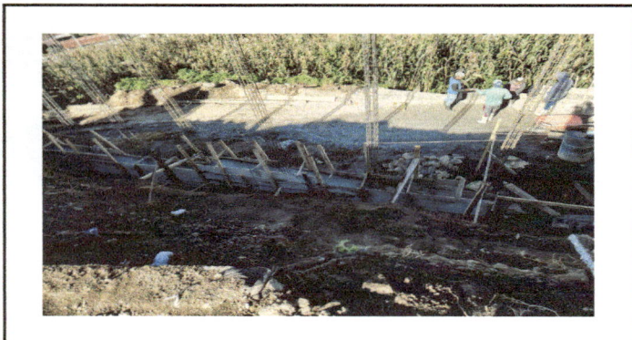
Foto 3: Cimiento de piedra.
