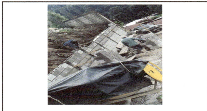
Foto 4: Inicio de colocación de block.
