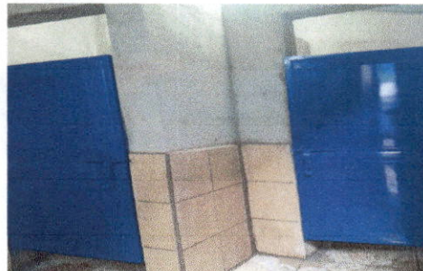
Foto 2: Puertas ya instaladas
