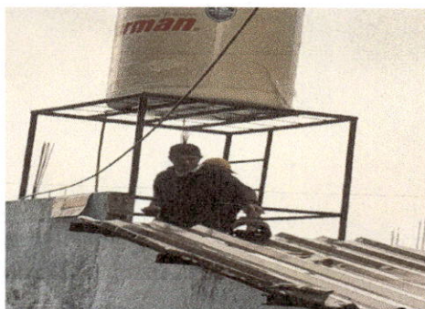
Foto 3: Tinaco instalado
