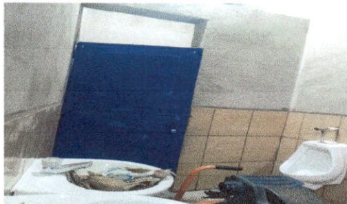
Foto 1: Puertas de baño ya instalada
