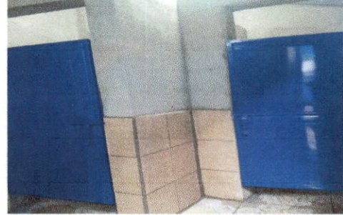
Foto 2: Puertas ya instaladas
