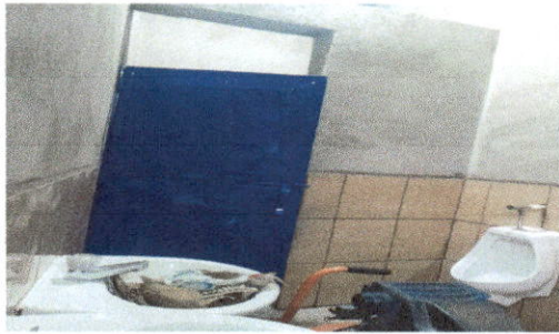
Foto 1: Puertas de baño ya instalada
