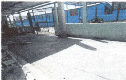
Foto 5: Reglón No. 16 Losa de patio, en el área de educación física para evitar charcos de agua.
