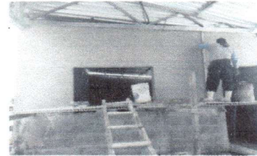
Foto 4: Reglón No. 10 Reparación de repello y cernido de paredes de cocina
