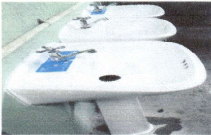
Foto 3: Reglón No. 10 Cambio de lavamanos en los sanitarios
