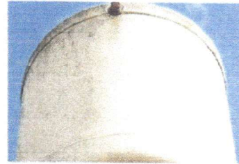
Foto 8: Reglón No. 18 Reparacion y mantenimiento de cisterna/deposito de agua de la cocina
