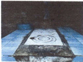
Foto 9: Reglón No. 20 Reparación o sustitución de área de cocina, estufa rural
