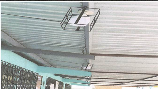
Foto 3: Pasillo: Colocación de focos y protección metálica enrejado a bombillas de corredores.
