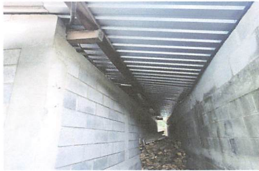
Foto 6: Levantado de pared y techo para colocación de leña.
