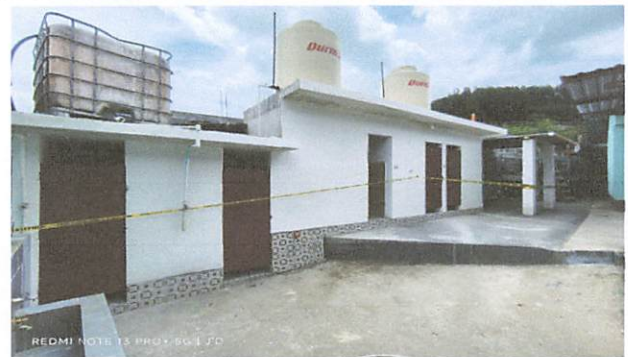
Foto 2: Culminación del levantado de pared para migitorios , 2 baños y techo adicional .
