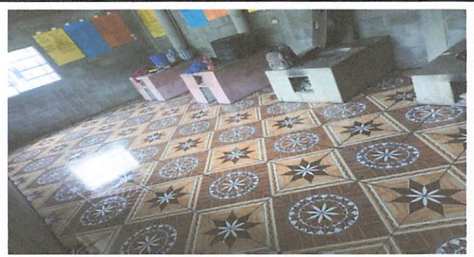
Foto 4: Culminación de colocación de azulejo a la cocina.
