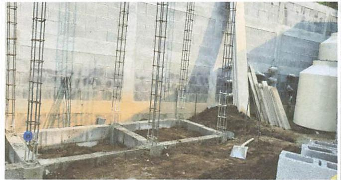
Foto 2: Cimiento para el levantado de pared de migitorios, baños y techo adicional .
