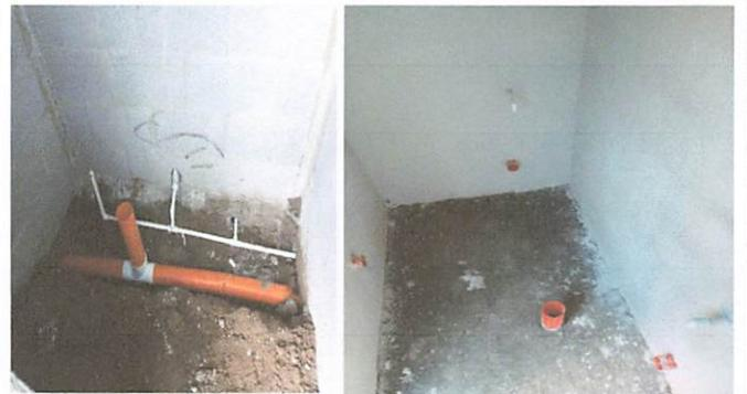
Foto 4: Tubería para la colocación de inodoros y migitorios.
