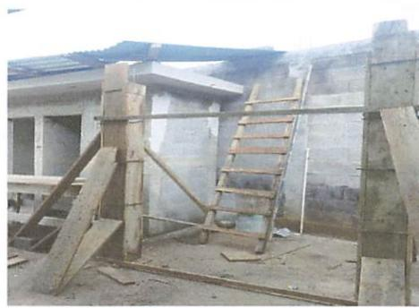
Foto 6: Levantado de pilares para colocación de techo sobre pila.
