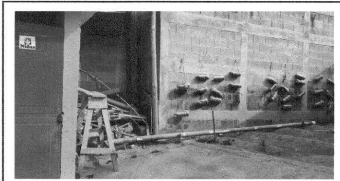
Foto 3: Levantado de pared para migitorios, 2 baños y techo adicional.
