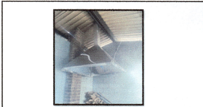
Foto 10: Culminación de colocación de campana de humo en cocina
