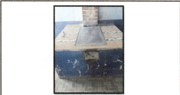
Foto 9: Culminación de reparación de plancha
