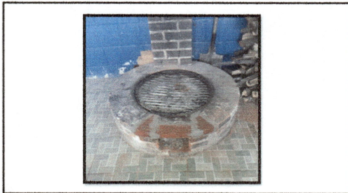
Foto 8: Culminación de reparación de cocina
