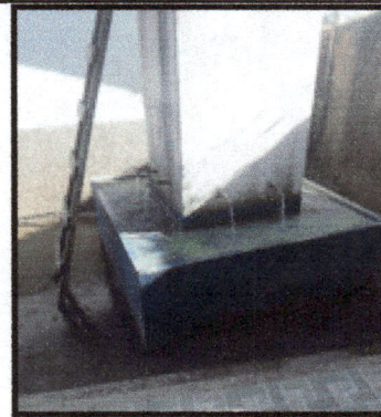
Foto 10: Reparación y mantenimiento de cisterna / lavamanos
