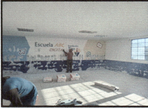
Foto 7: Reparación de repello y cernido de paredes
