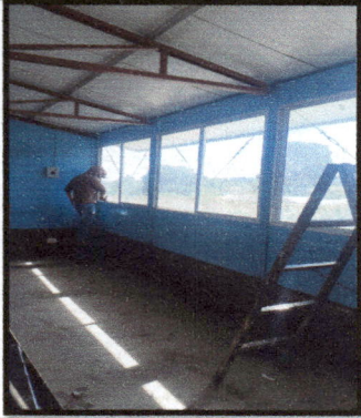
Foto1: Mantenimiento de ventanas corredizas
