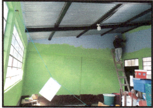
Foto 2: Pintado de aulas
