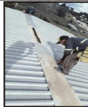
Foto 4: Cambio de techo en salón
