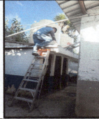
Foto 8: Reparación y mantenimiento de cisterna / deposito de agua
