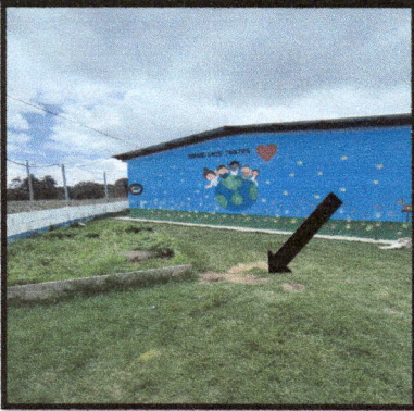
Foto 9: Limpieza de fosa septica
