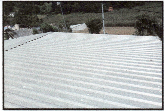
Foto 8: Cambio de techo en aula
