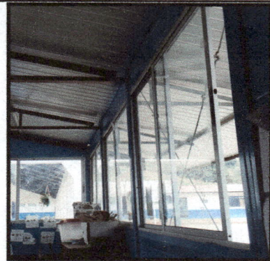
Foto 4: Mantenimiento de ventanas corredizas
