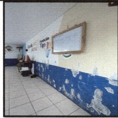
Foto 10: Reparación de repello y cernido de paredes
