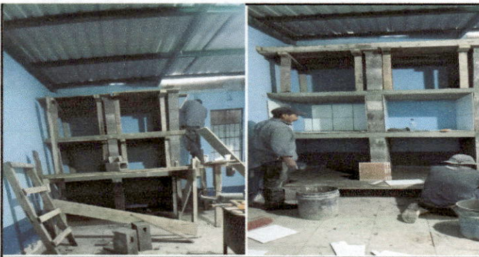
Foto 5: realización de trinchante de concreto en area de cocina.
