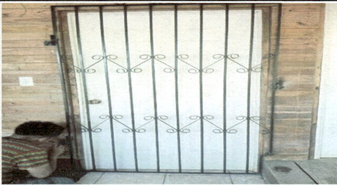
Foto 3: elaboración de reja para puerta para aula de tercer nivel.
