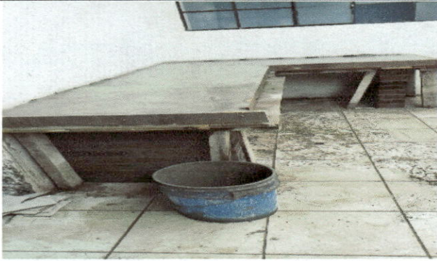
Foto1: realización de mesa de concreto en area de cocina.
