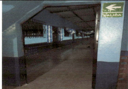
Foto 4: colocación de puerta recortada.
