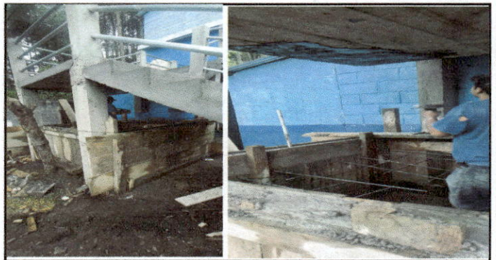
Foto 6: realización de pila con dos lavaderos.
