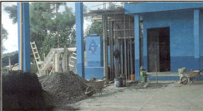
Foto 3: Elaboración de gradas con un total de 17 m.
