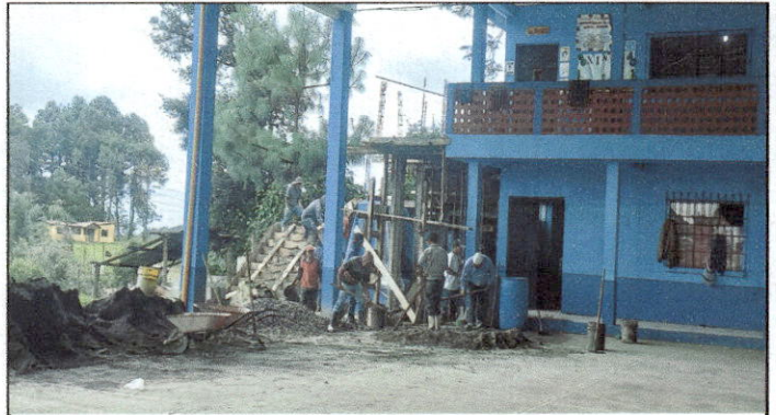
Foto 4: Elaboración de gradas con un total de 17 m.
