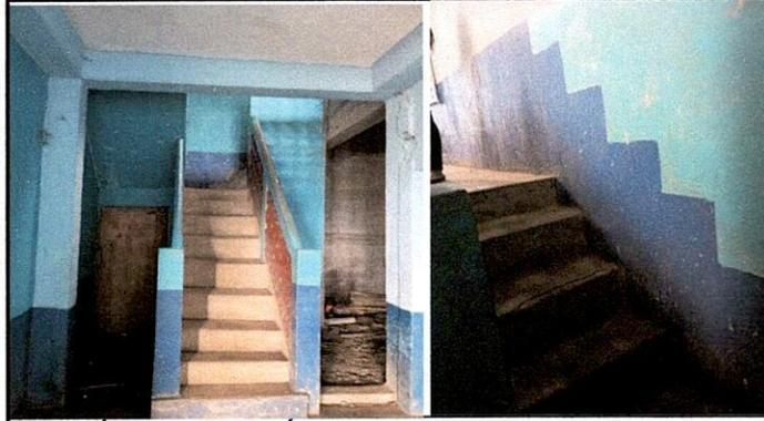
SUSTICIÓN DE GRADAS MÁS ANCHAS PARA FACILITAR EL TRANSPORTE DE MATERIALES Y ALIMENTOS AL SEGUNDO NIVEL DONDE SE UBICA LA COCINA.
