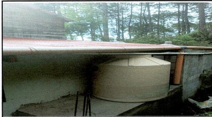
CONSTRUCCIÓN DE UNA BASE DE METAL PARA ELEVAR LA PRESIÓN DEL AGUA QUE LLEGA A LA COCINA CON UNA ESCALERA PARA DARLE MANTENIMIENTO AL DEPOSITO.
